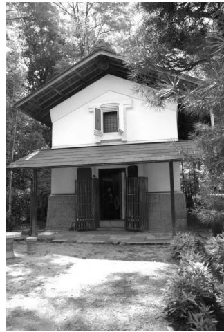
写真5 村野啓一郎家土蔵A3 外観
