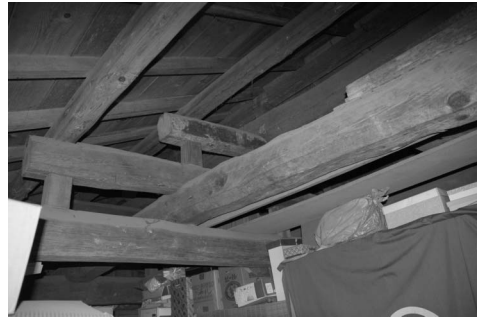
写真22 同上土蔵F 2階内部
