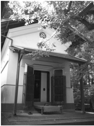
写真1 村野啓一郎家土蔵A1 外観
