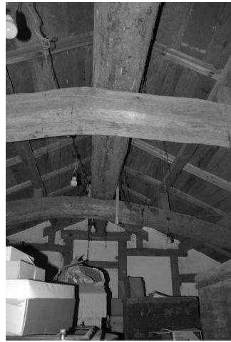
写真10 同左土蔵C1 2階内部
