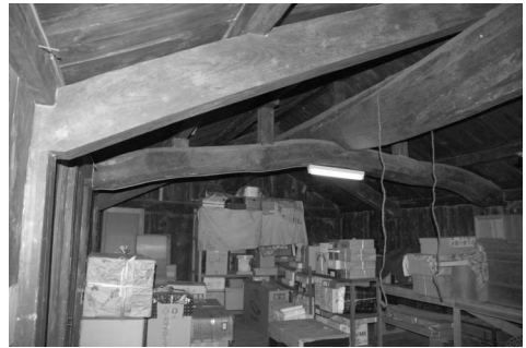
写真6 同上土蔵A3 2階内部
