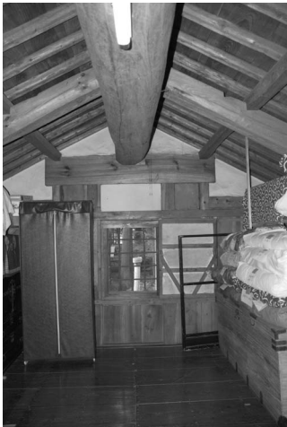
写真2 同上土蔵A1 2階内部
