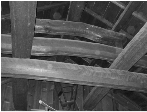
写真20 野寄敏雄家土蔵E 2階内部
