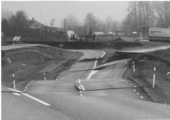
Fig. 1 Pictures of actual land subsidence
