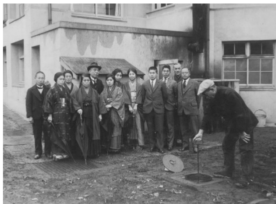
図1. メタンガス発生装置発火試験 （1929（昭和4）年11月25日）
