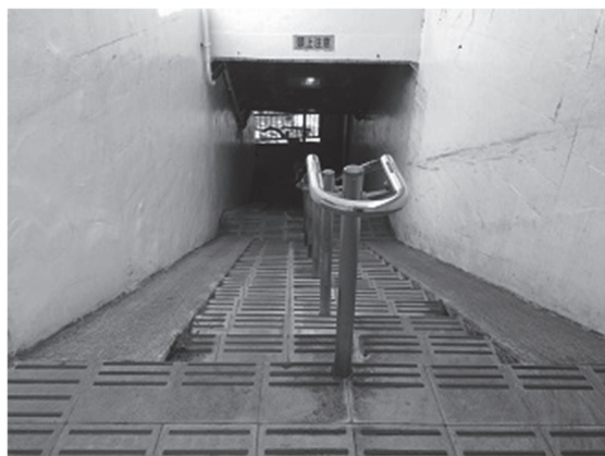
Fig.4 環状八号線アンダーパスの写真
